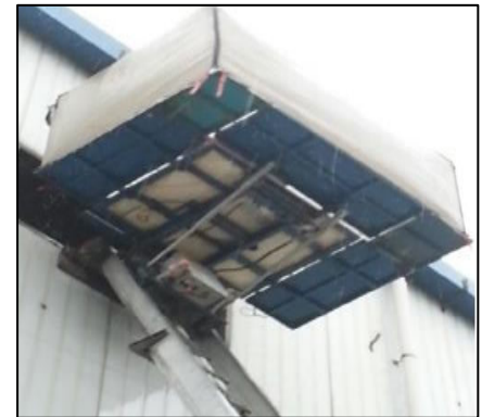
반출입구 tarpaulin 천막 설치
