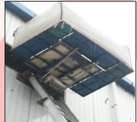
반출입구 tarpaulin 천막 설치
