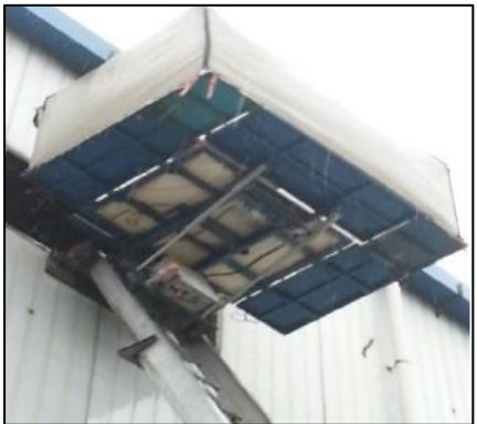
반출입구 tarpaulin 천막 설치
